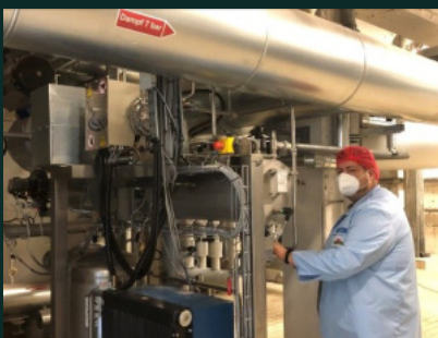
Schwarzwaldmilch Offenburg Druckreduzierung anstelle eines Regelventils
