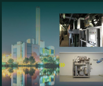
GMVA Niederrhein Druckreduzierung anstelle eines Regelventils
