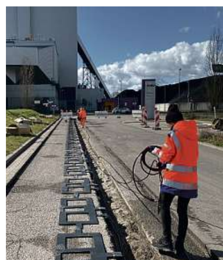
Die Ladestrecke auf dem EnBW-Gelände wird errichtet. FOTO ENBW
